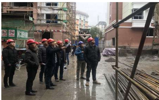
图1 全面检查施工条件
