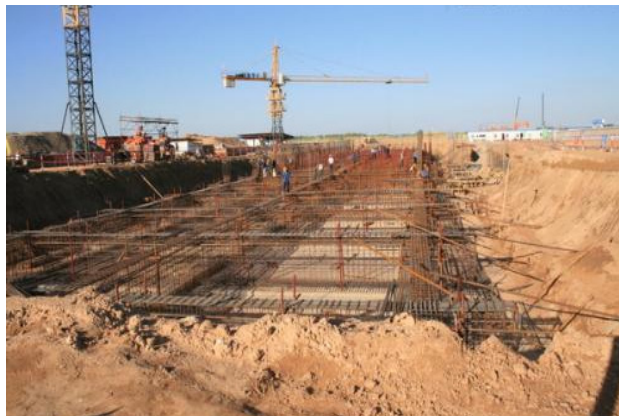
图1 土木工程施工现场
