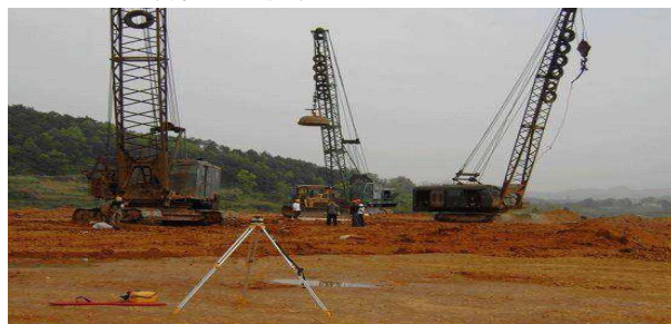
图1 强夯施工法处理地基
