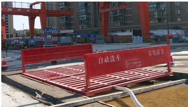
图1 利用节水设备控制现场施工用水量
