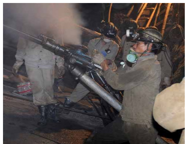
图1 水利隧洞锚杆支护技术示意图
