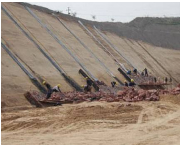
图1 公路路基高边坡施工示意图
