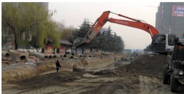
图1 地下管线施工现场图
