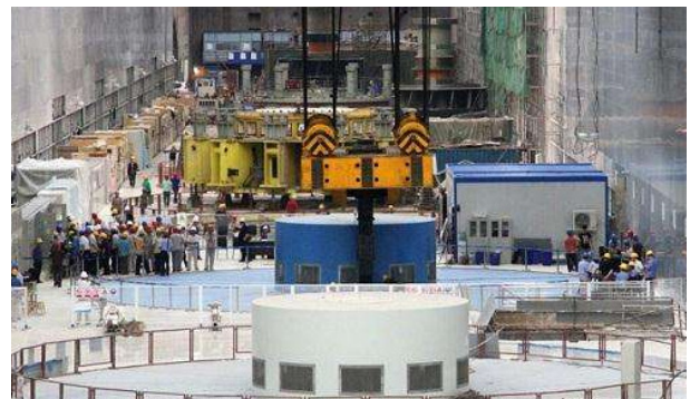
图1 机组超速试验现场图
