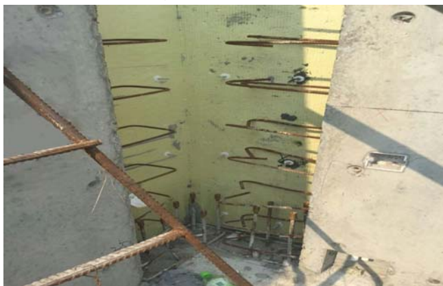
图4 L型PCF板现场安装图
