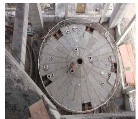
图4 拱顶掀开的顶板预留安装扒杆
