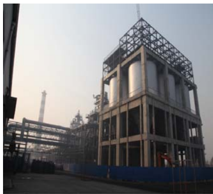
图1 东海炭素(天津)6万吨/年炭黑工程的成品储罐
