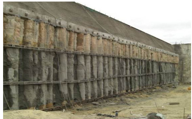
图2 预应力锚索施工技术
