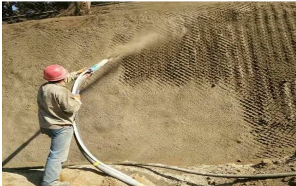
图1 锚喷支护施工技术
