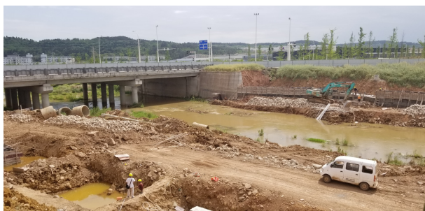
图1 水利工程施工监理现场示意图
