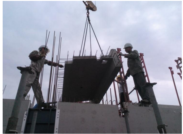
图2 预制阳台吊装
