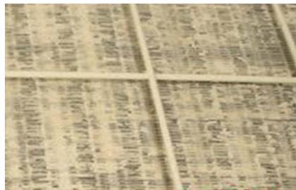
图4空气冷却器翅片堵塞严重
