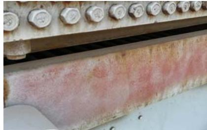
图3空气冷却器四周封堵不严,漏风严重
