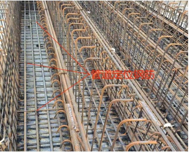
图4 布置PE管定位钢筋
