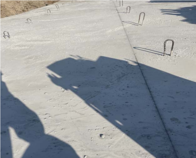
图3 支架基础设置拉环
