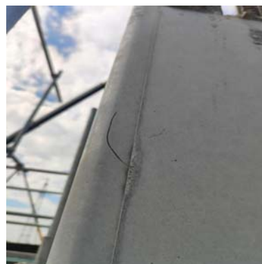
钢筋绑扎绑丝朝外造成夹丝现象
